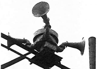
①防災行政無線の屋内受信機 ②今回の土砂災害では鳴らされなかった防災用サイレン
